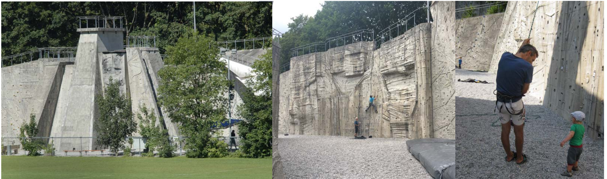
A Anlage heute - Betonaußenanlage
