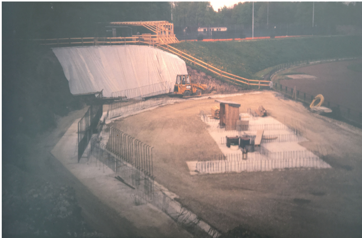
Fundamente Stützmauer und Türme. Anschlussbewehrung der Wände sitzt mittig, dh. Fundament/versiegelte Fläche ist kaum größer als die sichtbaren Wände/Türme
