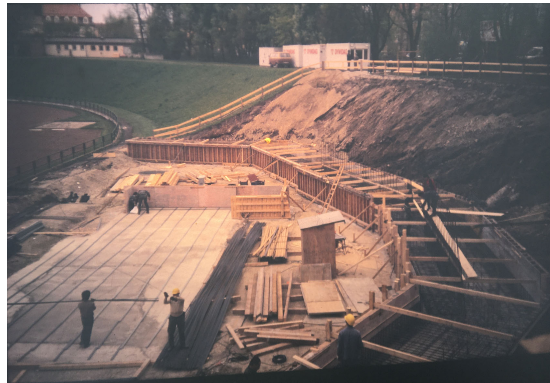
Fundamente Stützmauer und Türme
