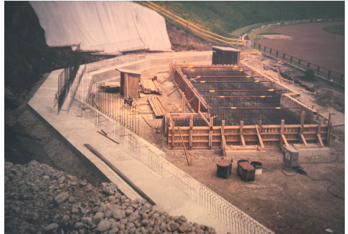
Fundamente Stützmauer und Türme. Anschlussbewehrung der Wände sitzt mittig, dh. Fundament/versiegelte Fläche ist kaum größer als die sichtbaren Wände/Türme
